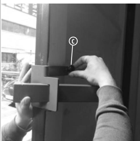
Fixieren Sie die Überfalle mit der Flügelmutter (C), so dass sie ohne Unterstützung an der Tür hält
