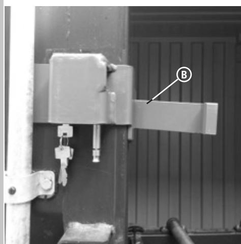
Drücken Sie gegen die Stange und ziehen sie nach rechts, bis der Winkel an den Innenfalte der linken Tür anschlägt
