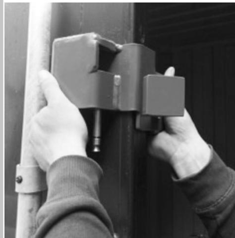
Schieben Sie die Überfalle über die linke Containertür. Der Schlosskasten muss nach außen zeigen
